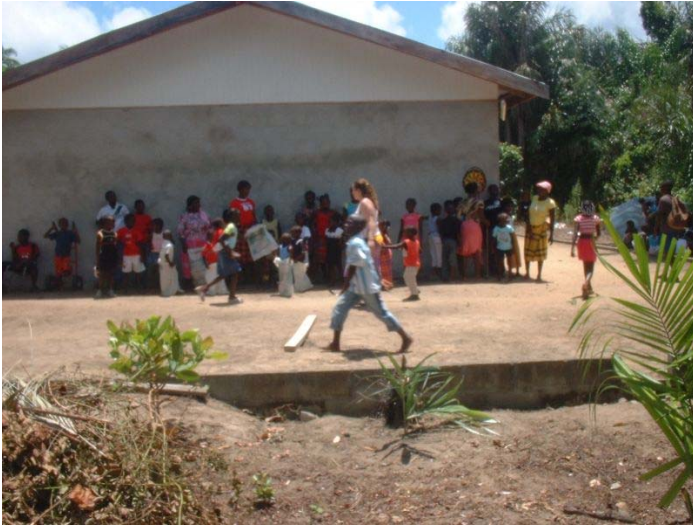
Fundering bibliotheekgedeelte te zien
